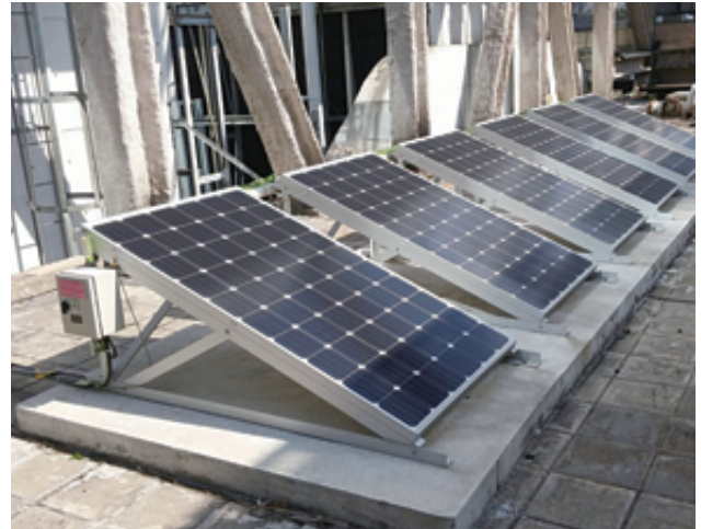
安裝太陽能電池板
